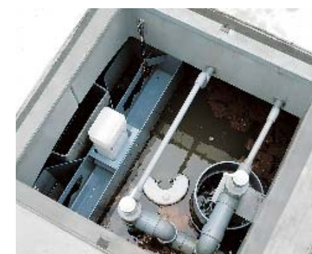
沈殿槽と消毒槽
