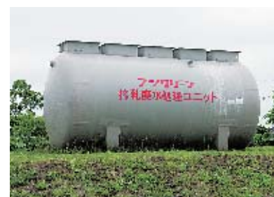
搾乳廃水処理ユニット
