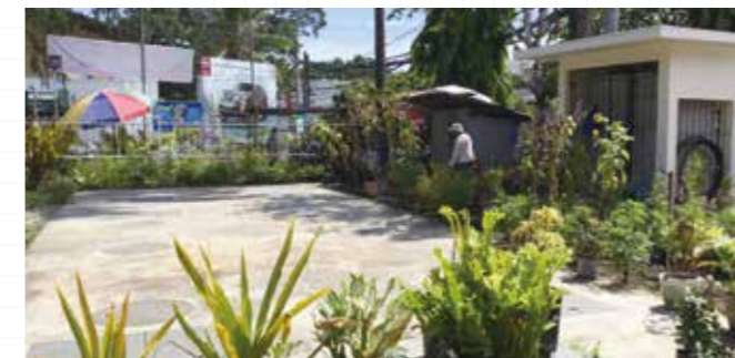
施工後の様子 Scene after construction
