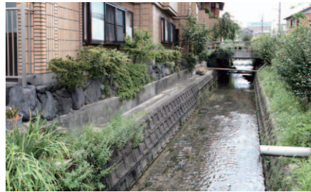
▲合併浄化槽に入れ替えたことできれいになった川
