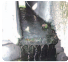
単独浄化槽設置地域の側溝の例
