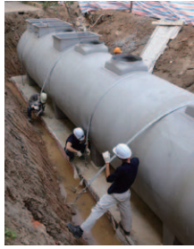
ベトナムの施工現場
