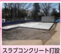
スラブコンクリート打設
