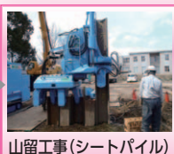
山留工事(シートパイル)
