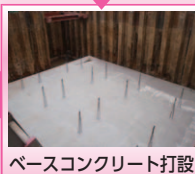
ベースコンクリート打設
