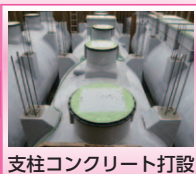
支柱コンクリート打設
