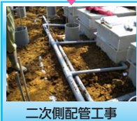
二次側配管工事
