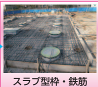
スラブ型枠・鉄筋
