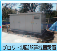
ブロウ・制御盤等機器設置
