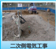
二次側電気工事
