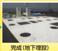
完成(地下埋設)
