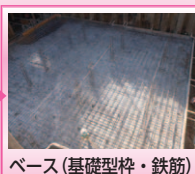
ベース(基礎型枠・鉄筋)
