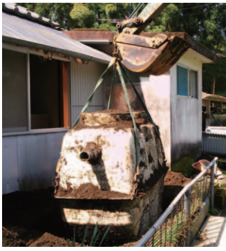
▲単独浄化槽の撤去（クレーン仕様のバックホウ）
