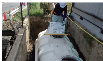
▲まるで小型浄化槽のような全高を実現した CA 型中型浄化槽。
