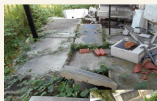
▲ 浄化槽周辺の 地割れ・陥没
