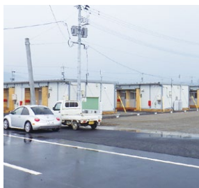
▲益城町のテクノ仮設団地
