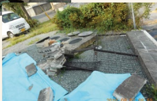
▲ 浄化槽周辺の 地割れ・陥没
