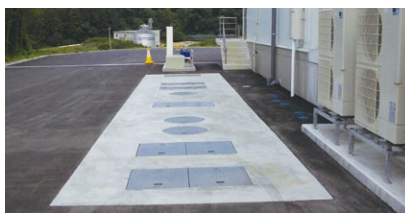
▲FRP管体の設置現場(地下埋設)
