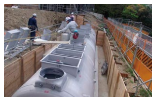
▲FRP管体の設置現場(地下埋設)
