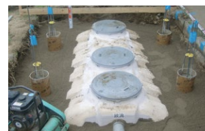
▲FRPユニットの設置現場(地下埋設)
