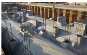
▲FRP管体の設置現場(地下埋設)
