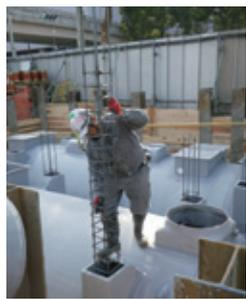
▲補強柱枠に柱鉄筋を差し込む様子
