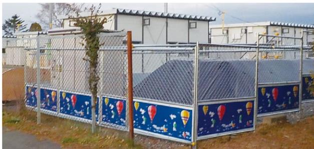
▲上厚真の応急仮設住宅に浄化槽を設置。保温のため浄化槽を土と黒いシートで被覆。
