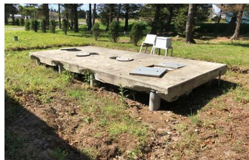
▲地震被害の様子(浄化槽周囲の地盤が沈下)
