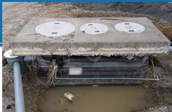
▲埋設土が流され槽本体が露出した状態
