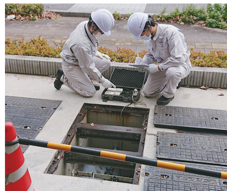
▲保守点検の様子
