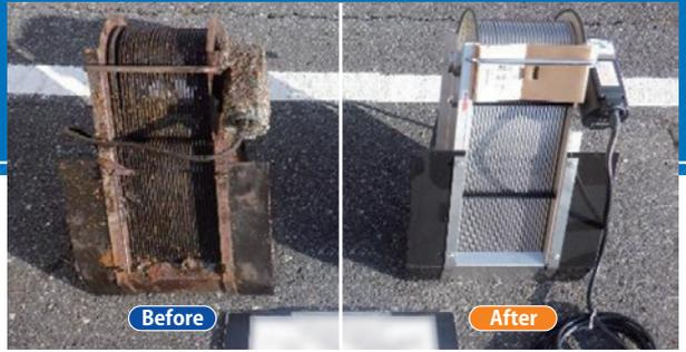
▲微細目スクリーンの交換前(左)と交換後(右)
