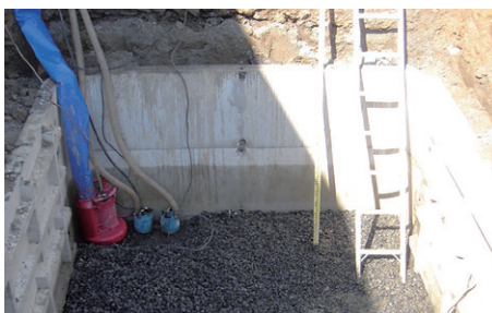
▲竈場ポンプ設置の様子
