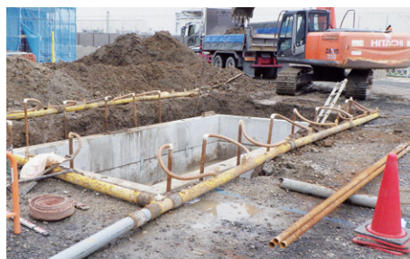
▲ウェルポイント工法の全景
