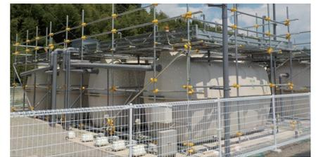
▲周囲にフェンスを設置し、立ち入りを制限した仮設住宅用浄化槽
