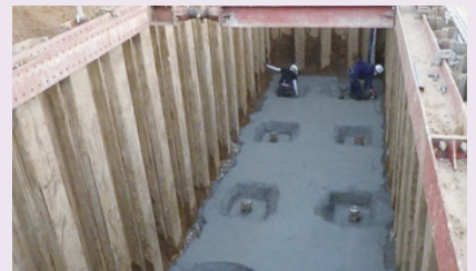
▲杭工事の様子
