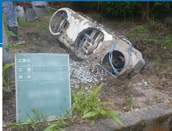
▲破損した浄化槽を消毒して撤去する様子
