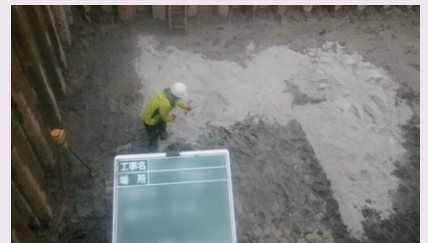
▲地盤改良の様子
