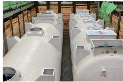
▲ I型管体据付後の様子
