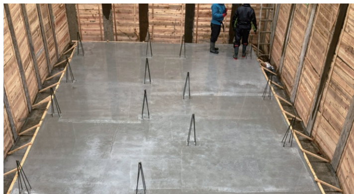
▲基礎コンクリート打設後の様子
