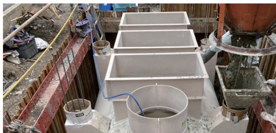
▲補強柱枠へコンクリートを流している様子
