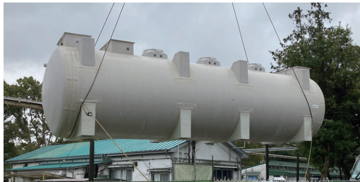
▲管体吊り上げの様子
