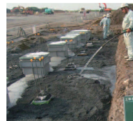
▲水締めの様子
