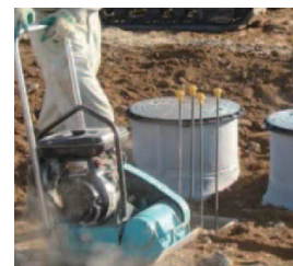
▲プレートコンパクターによる転圧の様子
