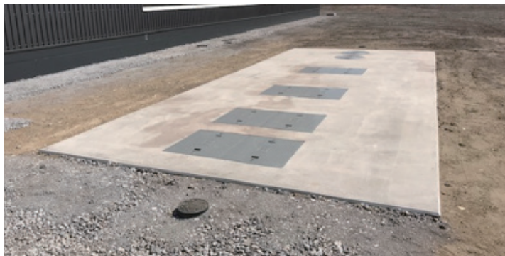
▲スラブコンクリート工事の様子
