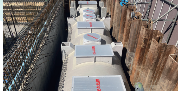
片側擁壁施工の様子▶
