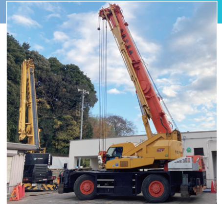
▲25t ラフテレーンクレーン
