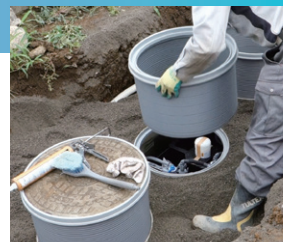
▲嵩上げ部材設置の様子
