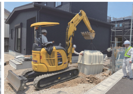
施主宅での浄化槽施工の様子
