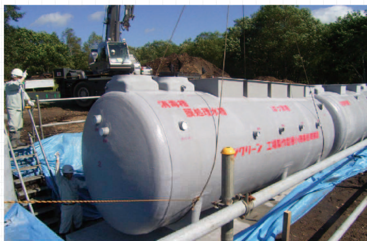
標茶町の社会実験の施工
