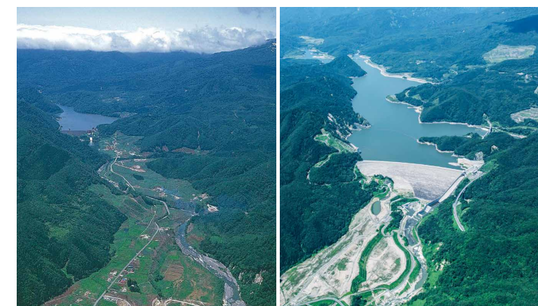
1953年に完成した石淵ダム(左)と、2013年に完成した胆沢ダム(右)。湖の大きさから総貯水量が格段に変わったことがわかります。(写真提供：胆沢ダム管理支所)
