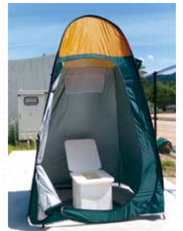
マンホールトイレを設置した状態
