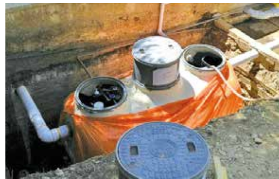
小型浄化槽設置工事の様子
