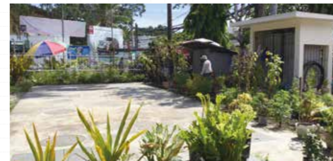
施工後の様子 Scene after construction
