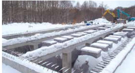
上：完成した施設外観 下：雪の中で行われた施工作業
