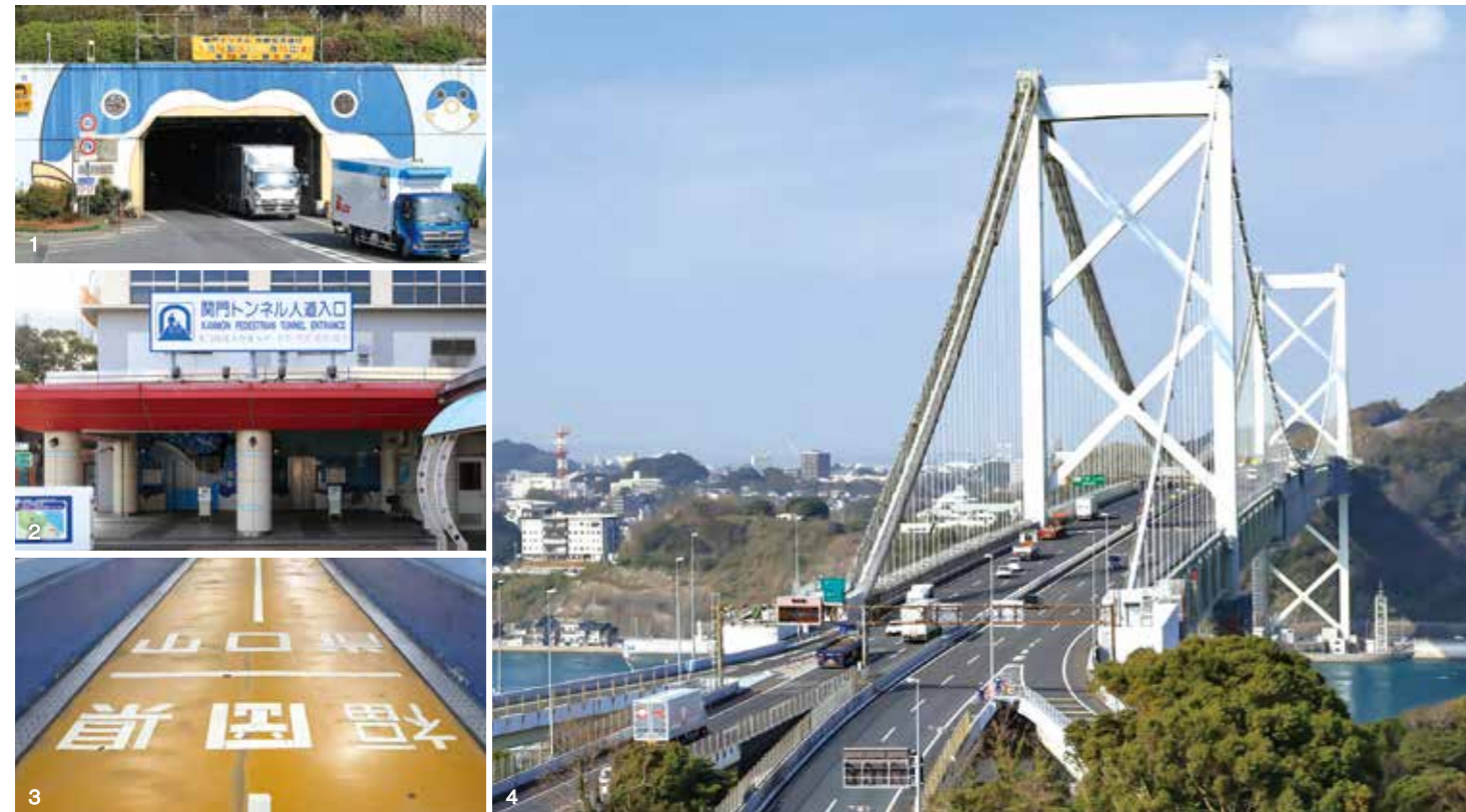
1. 山口県下関市と福岡県北九州市を結ぶ国道2号線が通る関門トンネル 2. 全長780メートルの歩行者用海底トンネルの下関側入口 3. 海底トンネルの中ほどにある福岡県と山口県の県境の標識 4. 関門海峡の一番狭まった「早瀬の瀬戸」に架かり、関門自動車道が通る関門橋は、全長1,068メートル、海面からの高さは61メートル
