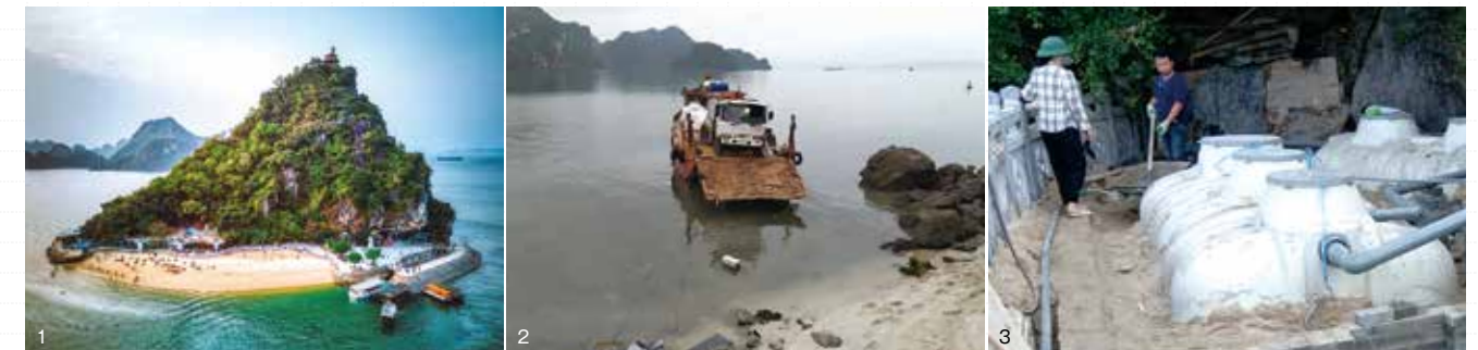
1. ビーチを楽しむため多くの観光客が訪れるTiTop島 2. 船を利用して搬入 3. 設置工事の様子
