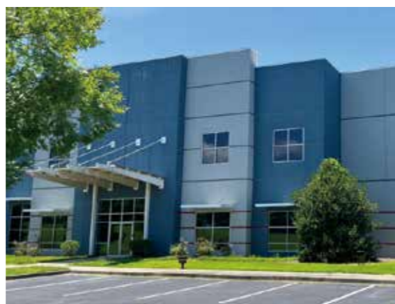
ジョージア州 新工場 外観
