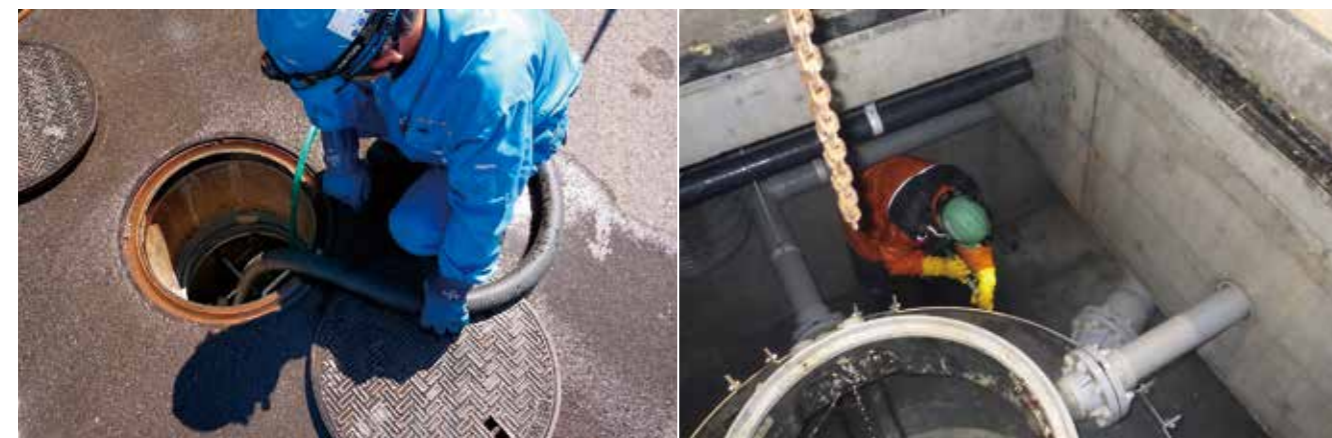
浄化槽・汚水槽の清掃現場。浄化槽は汚泥を除去する清掃を怠ると機能低下につながり、悪臭の原因になるだけでなく、汚れた排水を流すこととなります
